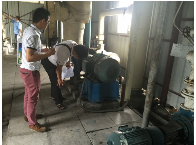
核查中华商务联合印刷公司电机改造情况
