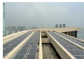
深圳海上世界酒店项目光伏照明工程
