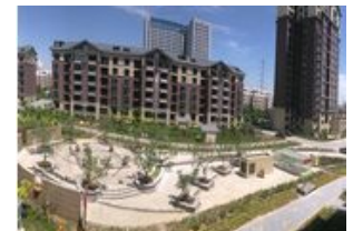
银川福满苑地下车库 PV-LED 照明工程
