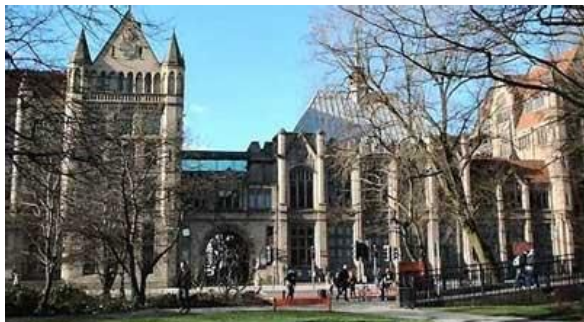
建筑节能工程管理者将趋于注册类
