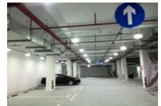
广州招商金山谷八期地下车库太阳能照明工程
