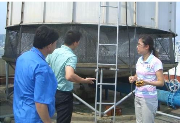
察看龙岗区检察院楼顶水塔
