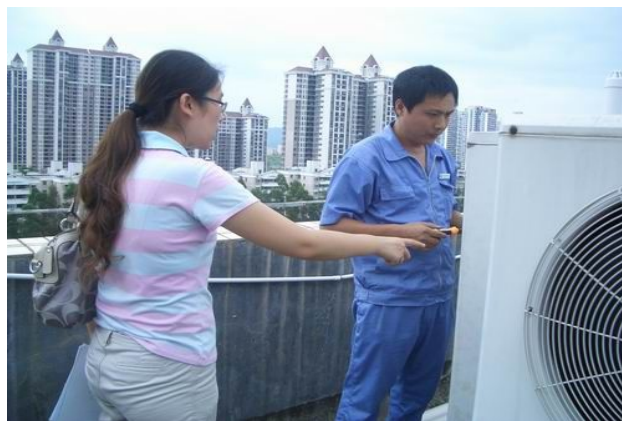
查看龙岗区妇幼保健院楼顶空调外机运行情况
