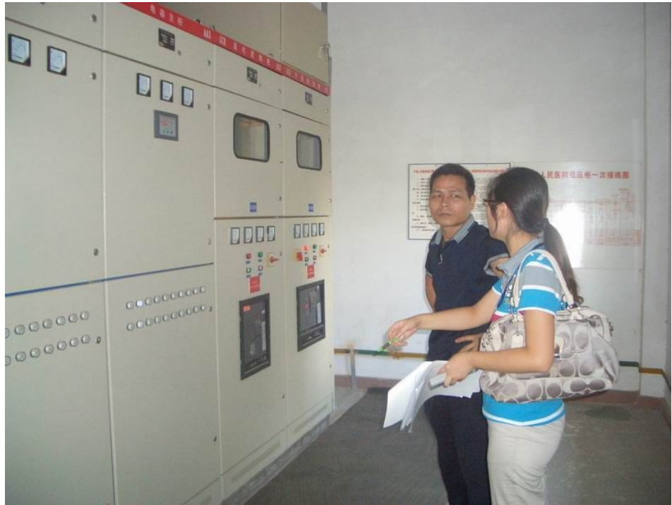
查看平湖人民医院配电柜房
