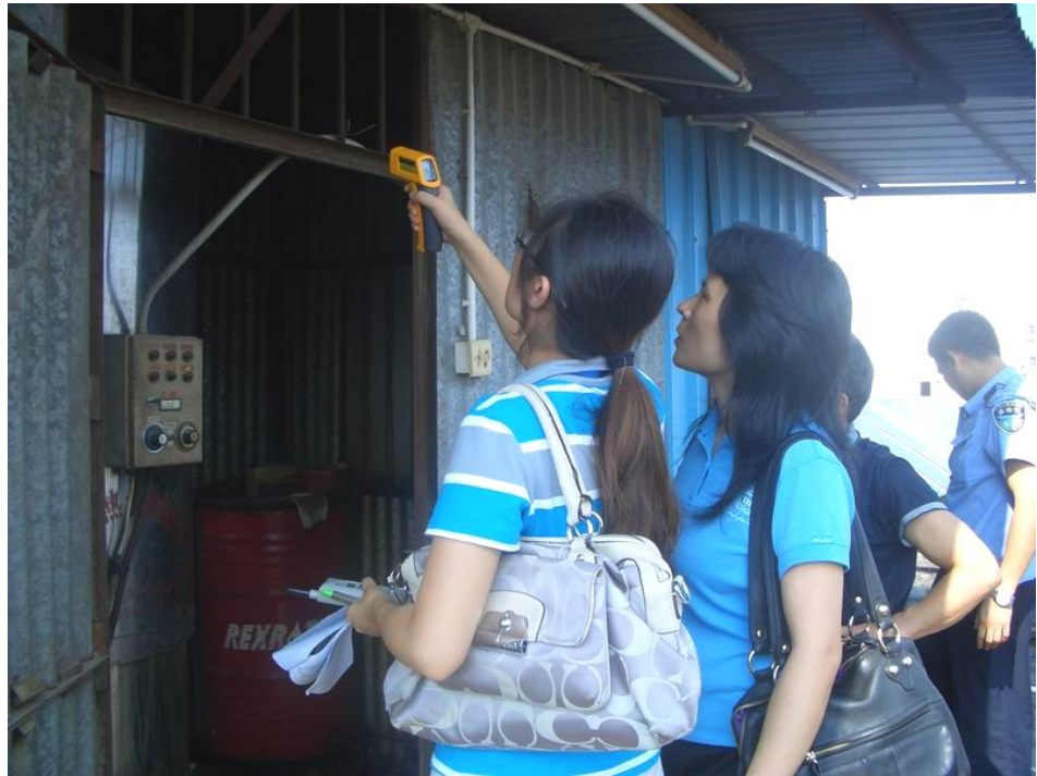
查看平湖人民医院大楼楼顶的锅炉间
