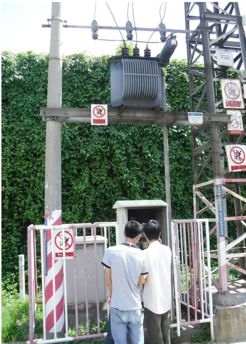
深圳市节能专家联合会工作人员在平龙西路变电站现场测试
