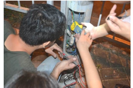
测量路灯用电情况
