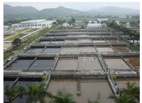
深圳水务集团滨河污水处理厂
