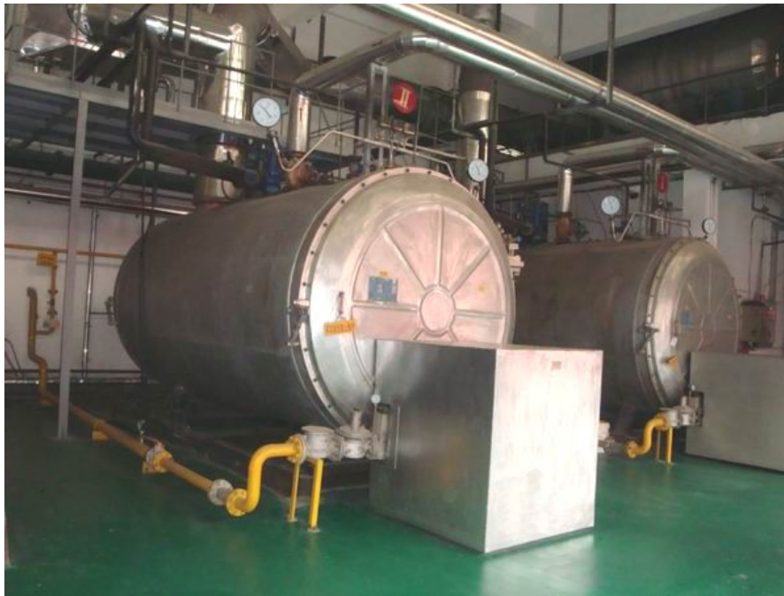
深圳维他（光明）食品饮料公司锅炉烟气节能改造项目
